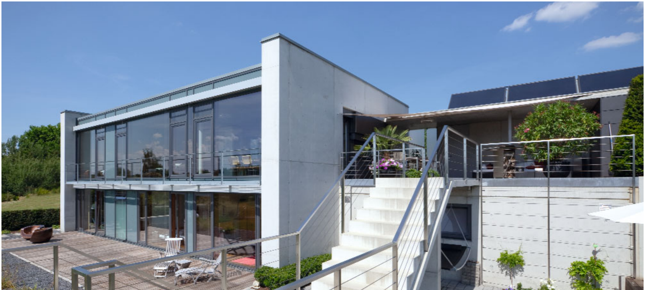
Montage sur toit plat
