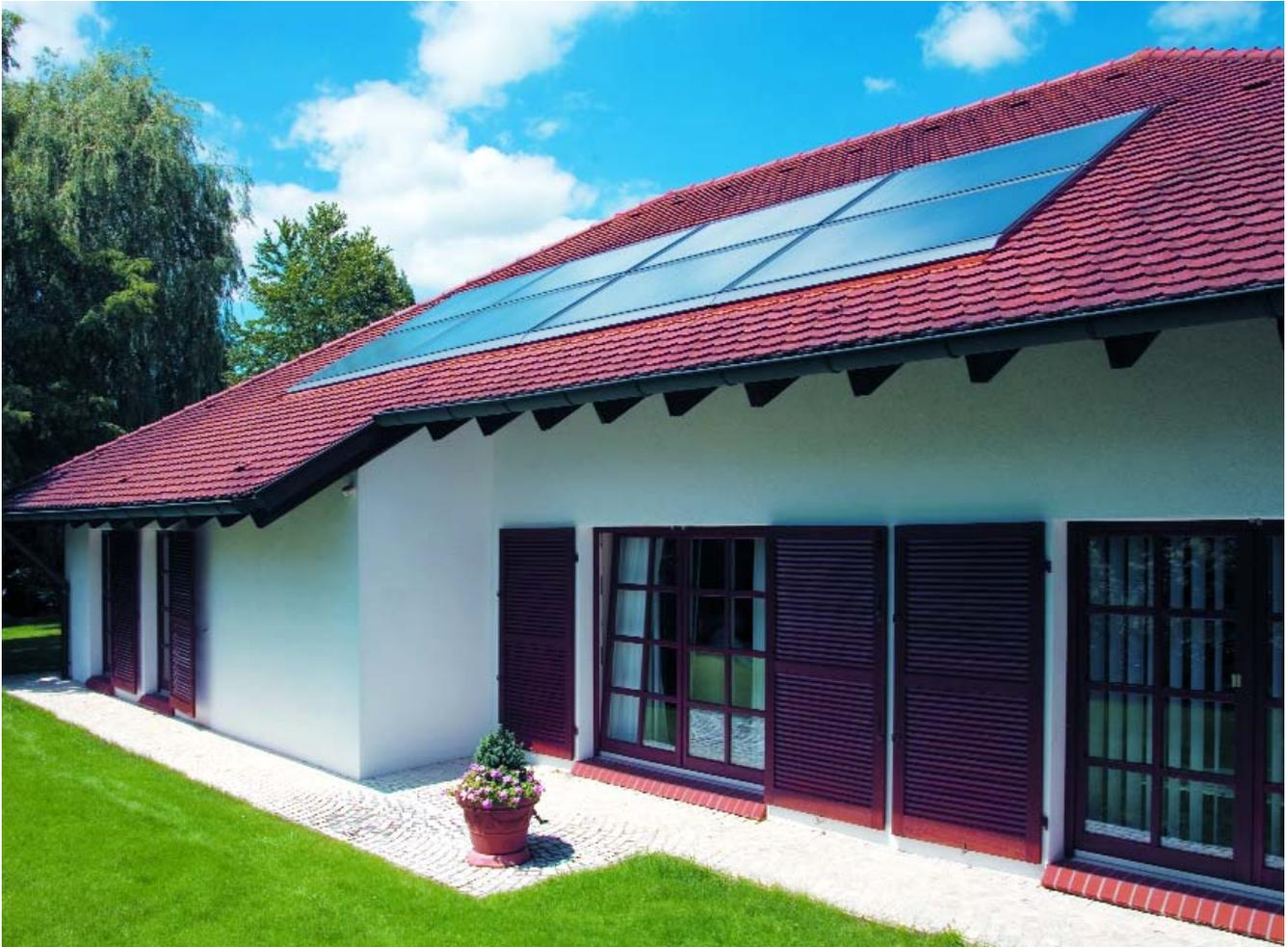
*Installation solaire Weishaupt reliée à un préparateur solaire et à une chaudière Thermo Unit-S*
